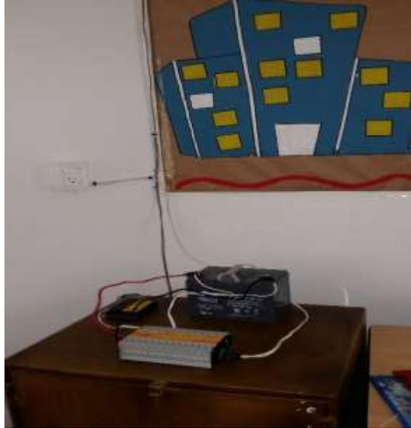
Conjunto de batería y regulador instalado en el salón de clases
