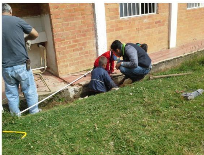
Ilustración 6: Instalación del Sistema de Riego Controlado
