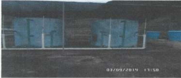
Visita planta antigua de tratamiento de agua.
