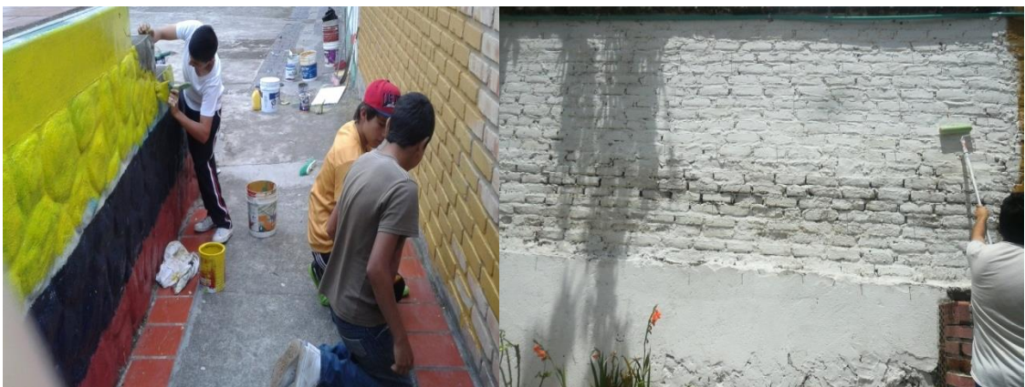
Adecuación de lugares de INSPILAR
