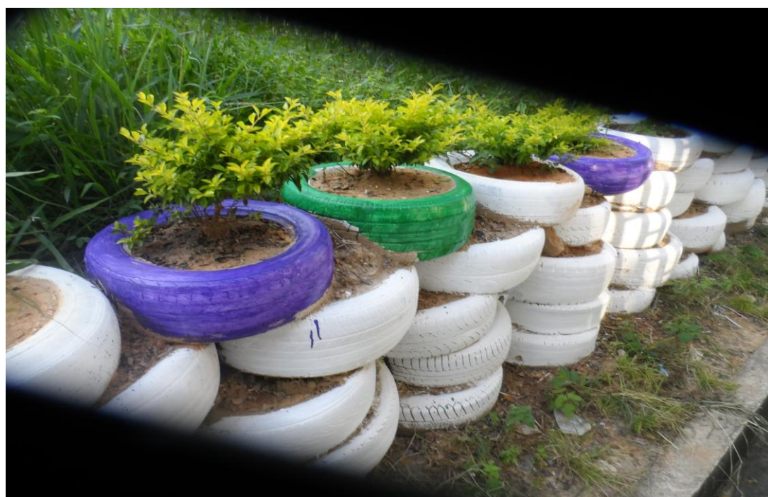
Construcción de una barrera inorgánica para evitar el arrastre por acción de la lluvia.
