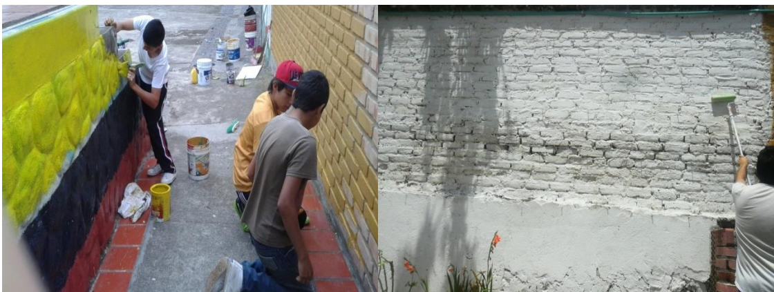
Adecuación de lugares de INSPILAR
