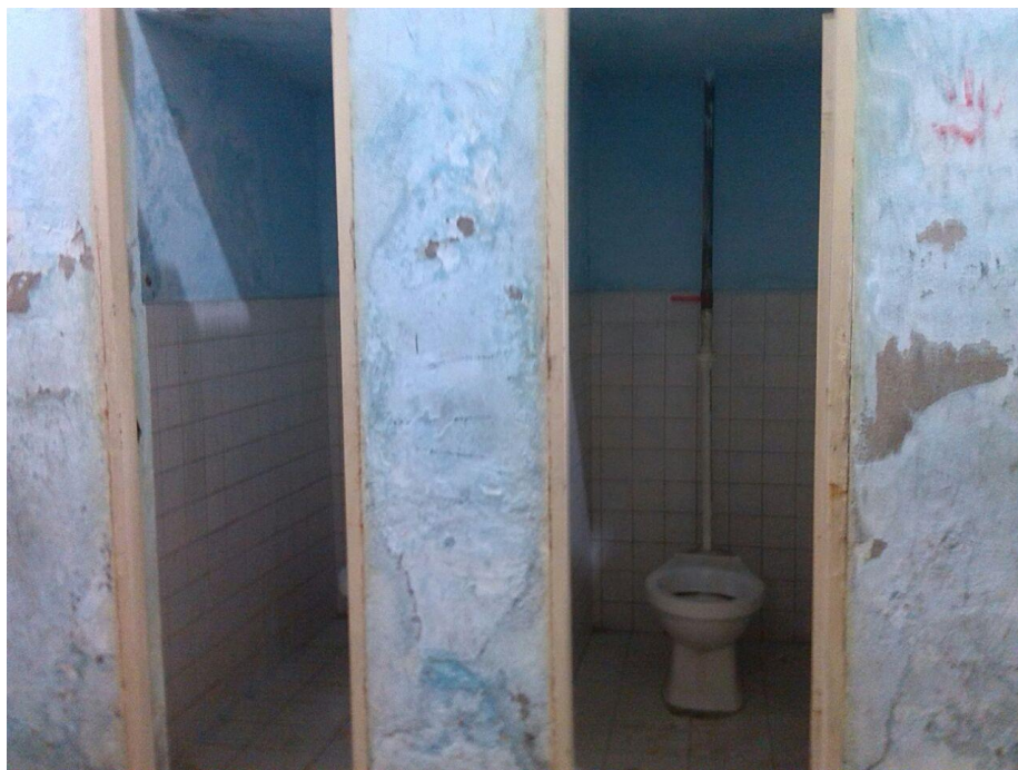
FOTO 10. Observación de las instalaciones del colegio
