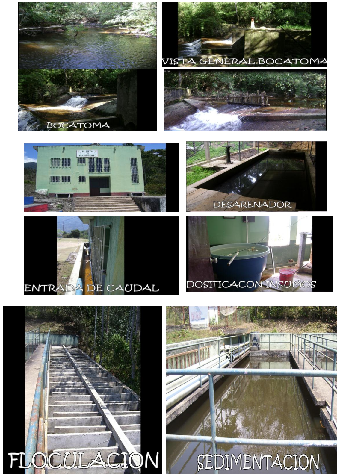
Figura 16.Planta de Tratamiento Antigua
