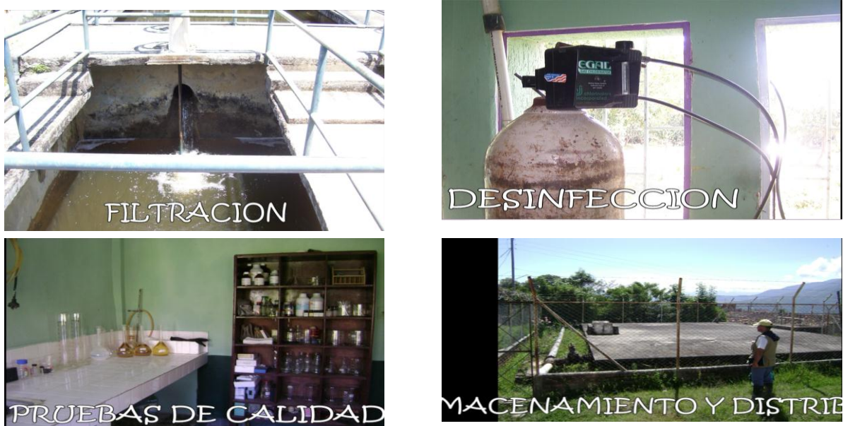
Figura 17 .Planta de Tratamiento Antigua
