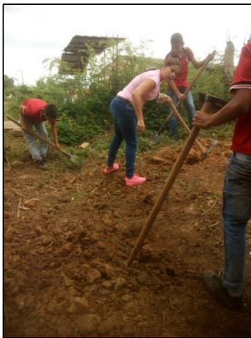
Ilustración 9. Remoción de tierra del terreno
