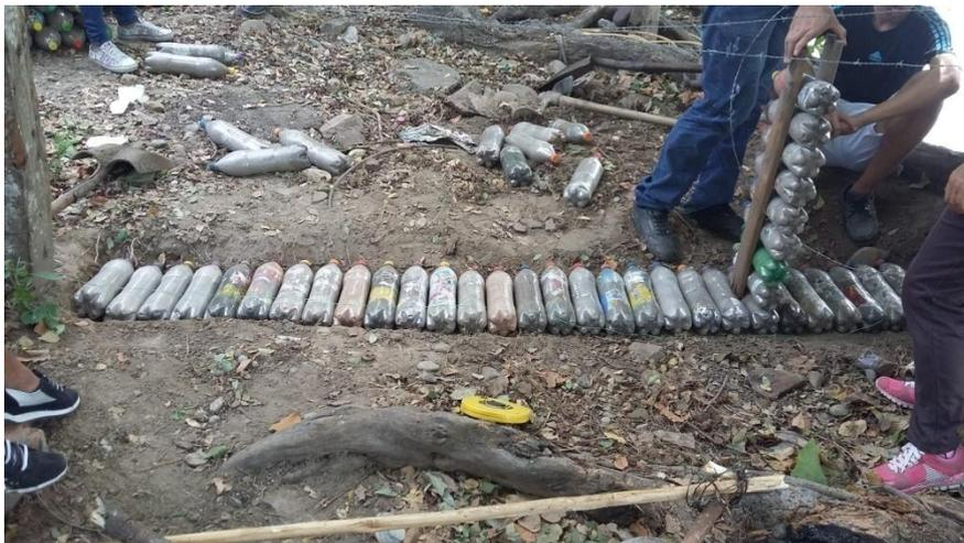
Foto 27. Iniciación de la elaboración del muro.
