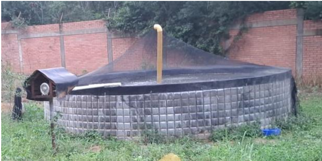
ESTANQUE DE GEOMEMBRANA
