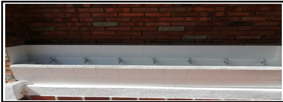
Foto No.2: ADECUACIONES FÍSICAS. Instalaciones de zonas de lavado de manos (Primaria)
