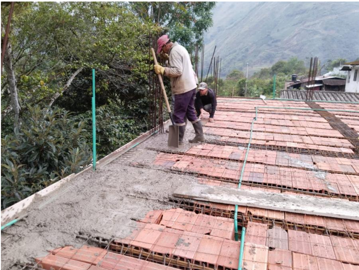
FINALIZACION PLACA PARA EL SEGUNDO PISO
