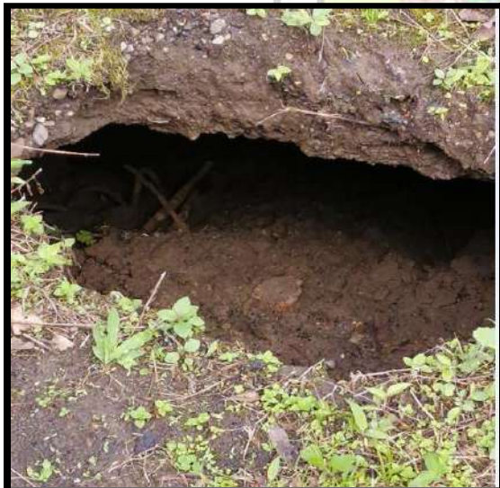
Terreno por donde pasa el pozo séptico y ha ido cediendo (se hizo un hueco)
