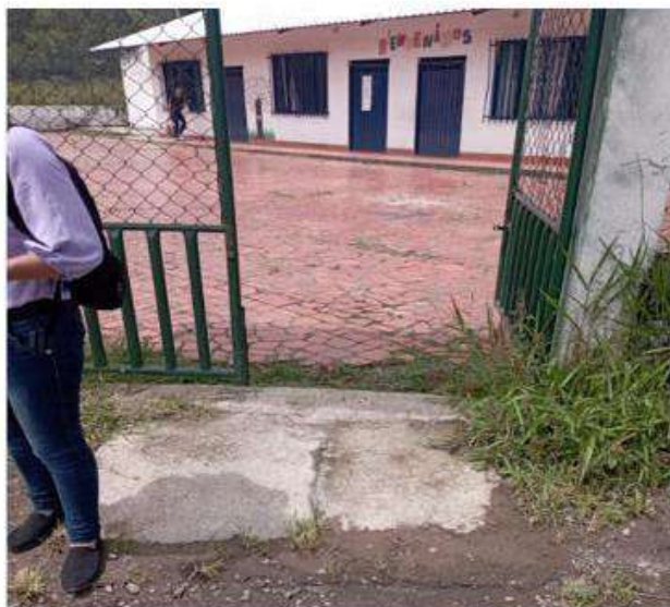
Entrada a la escuela ubicada en pleno orillo de la carretera, lo que representa un gran riesgo.
