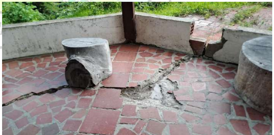
Piso de kiosco al lado de kiosco
