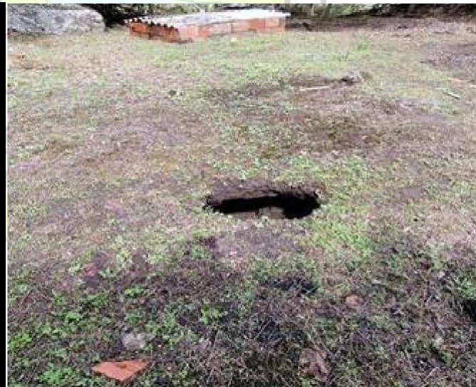
Terreno por donde pasa el pozo séptico y ha ido cediendo (se hizo un hueco)
