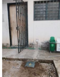
Puesta polo a tierra con tapa de inspección
