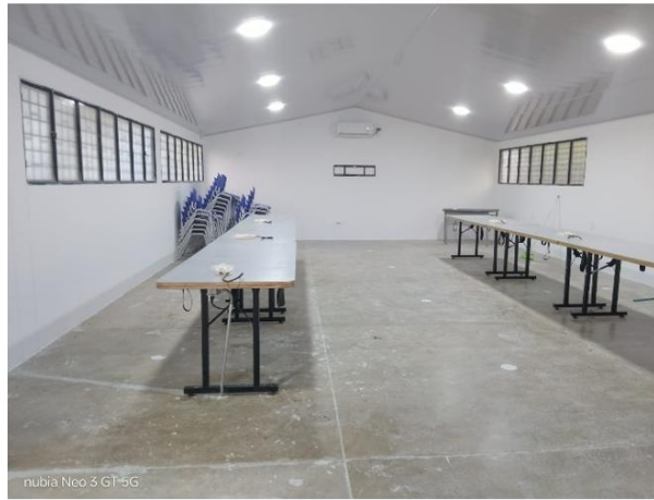
Sala de informática terminada con instalación de equipos individual
