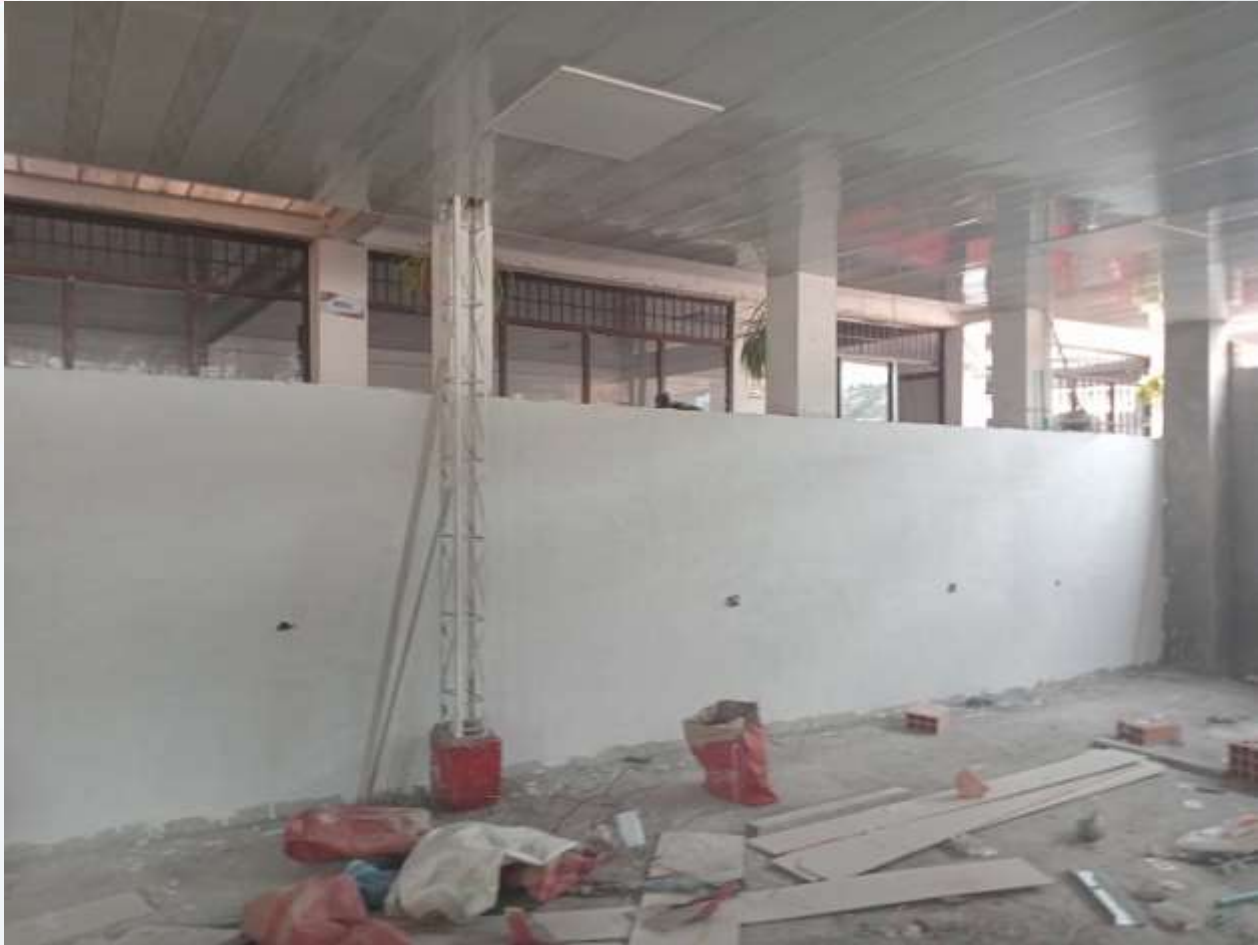
CONTRATO DE MANTENIMIENTO DE INFRAESTRUCTURA ADECUACIÓN DEL AULA PARA MEDIA TÉCNICA
