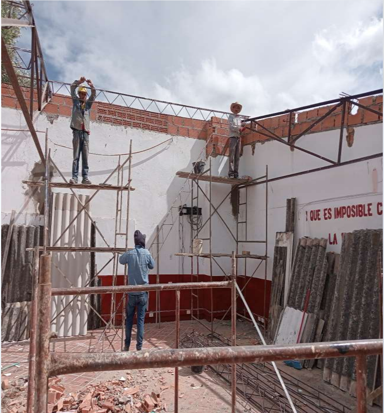
CONTRATO MANTENIMIENTO DE INFRAESTRUCTURA ARREGLO DE LOS TECHOS DEL AULA DE INFORMÁTICA E INGLÉS
