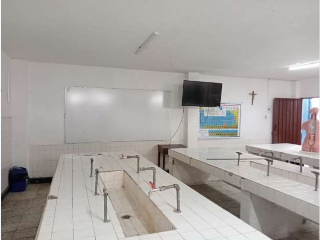
CONTRATO DE MANTENIMIENTO DE INFRAESTRUCTURA. ARREGLO DEL LABORATORIO DE CIENCIAS
