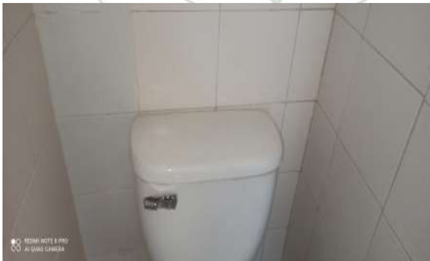
Instalación de arbolito de sanitario baño segundo piso niños.
