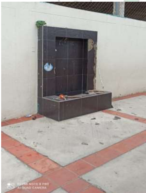
Demolición de volumen de ladrillo y cerámica patio.
