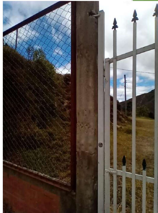
Arreglo de portón
