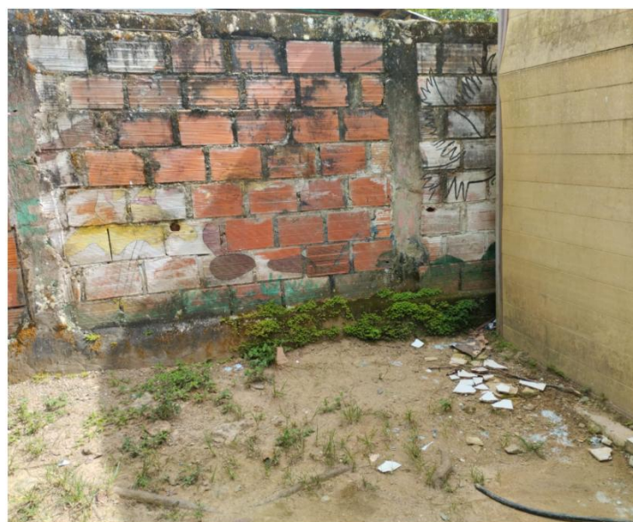
Área para Batería sanitaria de la sede Principal
