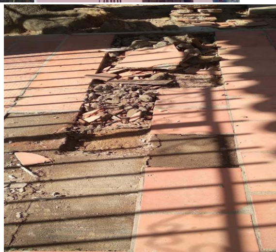
ADECUACION TEATRO SEDE 2
