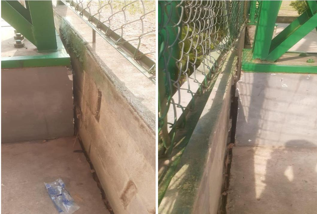
El muro que debe estar unido a las zapatas de soporte de estructuras de las columnas metálicas se encuentra separadas a 3cm aproximadamente, situación que posiblemente se está presentando porque esta zona de la cancha el costado izquierdo fue construida sobre relleno el cual está erosionándose continuamente.
