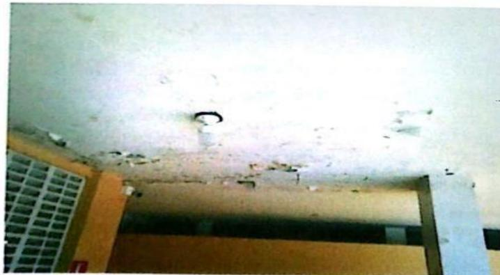
Foto 3 Deterioro de las placas debido a las filtraciones
