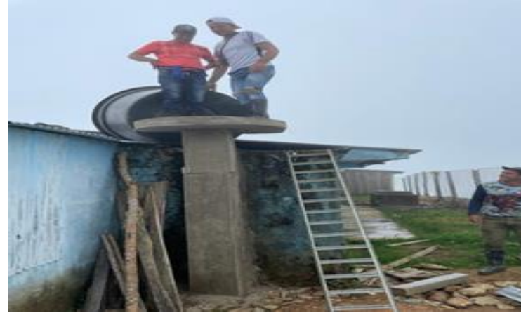
CONSTRUCCION DEL TANQUE AEREO
