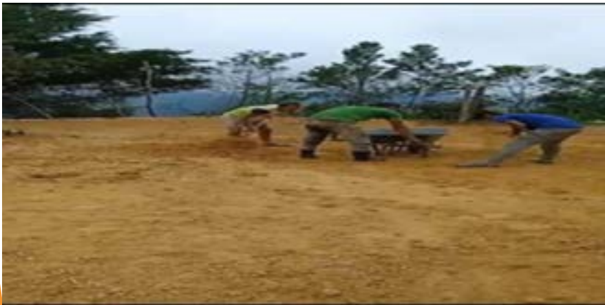
NIVELACION DEL TERRENO DEPORTIVO
