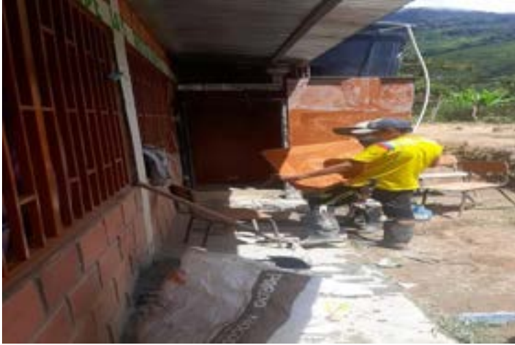
ADECUACIÓN DE LA SEDE “PINTURA”
