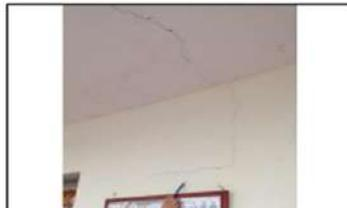
Fisuras longitudinal y trasversal en la placa de entrepiso del pasillo de transición.
