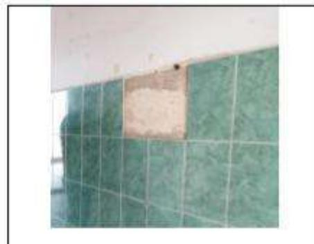
Debido al asentamiento se evidencia la ruptura de la cerámica de la pared, y al tacto, se siente el hueco del desprendimiento de muchas más.
