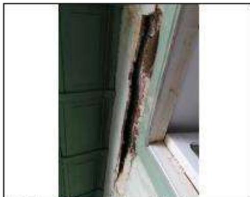
Debido a la humedad se evidencia desprendimiento del revestimiento de la pared en la fachada
