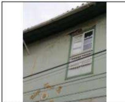
Debido a la construcción de un portón en la fachada de la institución, se ha venido presentando un asentamiento y opresión en la estructura colocando en riesgo la estructura en adobe.
