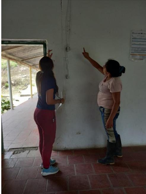
Sede El Placer cables de luz sueltos y defectuosos
