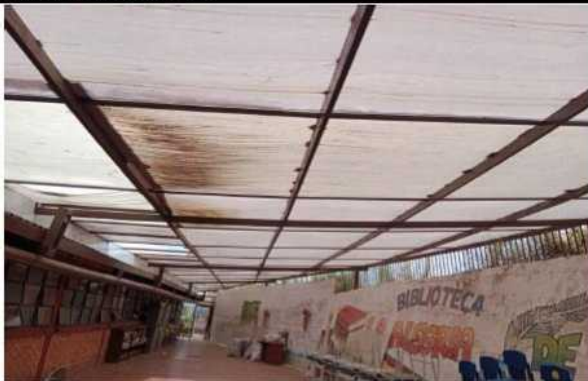
ANTES CUBIERTA POLICARBONATO
