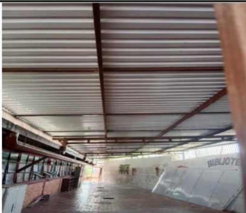
DESPUES: CUBIERTA CON MATERMIL
