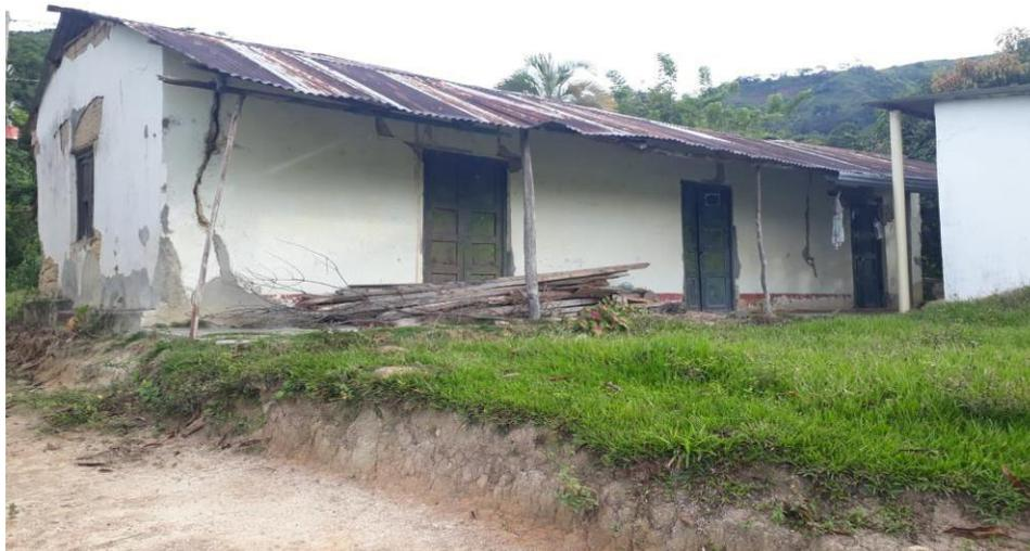
*El salón ubicado en la sede Alto móvil se encuentra en condiciones deplorables. Sus paredes, construidas en tapia, presentan grietas profundas y evidencian un deterioro estructural avanzado, lo que representa un peligro inminente para la seguridad de estudiantes y personal docente.*
