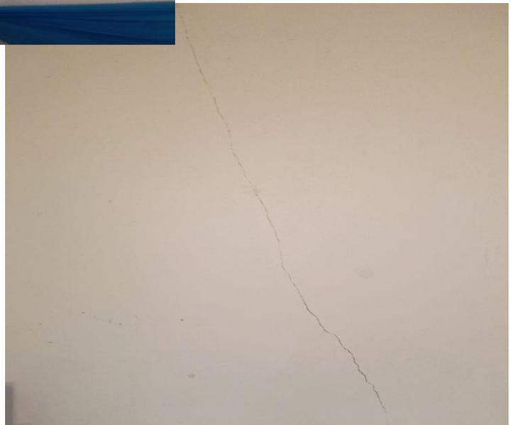
*Los sismos recientes han ocasionado daños estructurales en la sede Las Cruces, evidenciados principalmente por el agrietamiento de sus paredes, lo cual constituye un factor de riesgo para la seguridad de sus ocupantes.*
