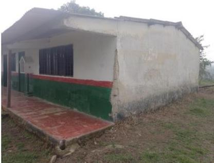
*La sede Mercedes altas presenta fisuras en muros, deterioro avanzado de mampostería en fachadas y desprendimiento de estructura de la cubierta. Adicionalmente, presenta deslizamiento en la zona perimetral de la sede educativa, ocasionando inestabilidad en el cerramiento en malla eslabonada, por su ubicación geográfica es afectada frecuentemente por tormentas eléctricas.*
