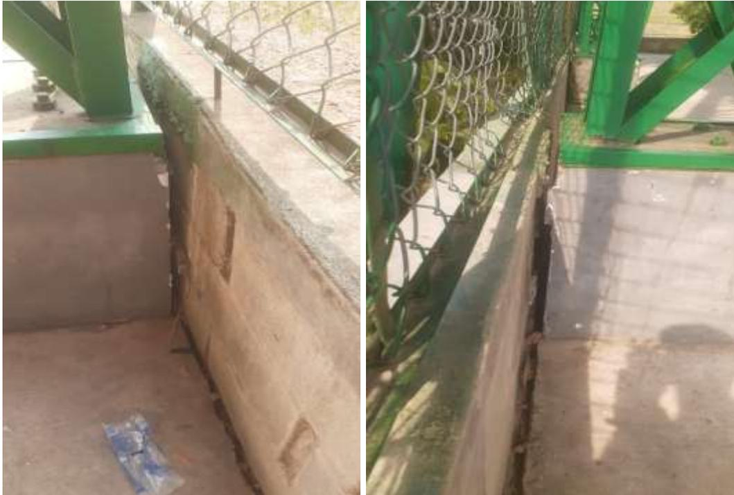
El muro que debe estar unido a las zapatas de soporte de estructuras de las columnas metálicas se encuentran separadas a 3cm aproximadamente, situación que posiblemente se está presentando porque esta zona de la cancha el costado izquierdo fue construida sobre relleno el cual está erosionándose continuamente.
