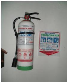
Recomendaciones: se recomienda señalar y demarcar el extintor como se muestra en la figura y no colocarlos a una altura mayor a 1.50 m del suelo. Y colocarlo en el exterior al lado de la puerta de acceso al aula.
