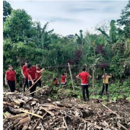
PREPARACION DE TERRENO
