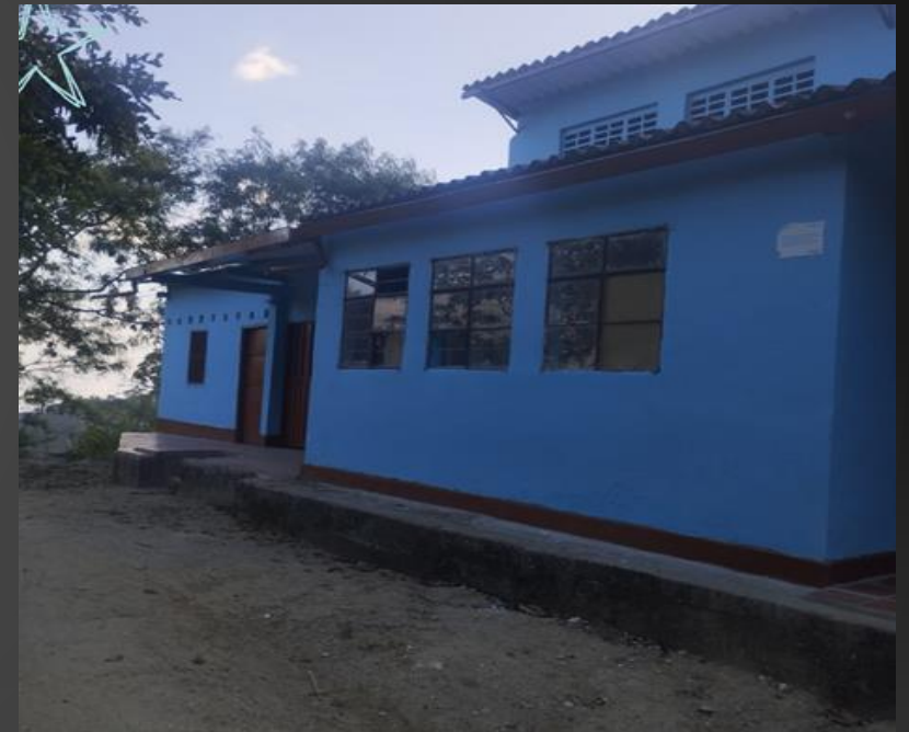
MEJORAMIENTO DE LA PLANTA FISICA SEDE CAMPO RICO
