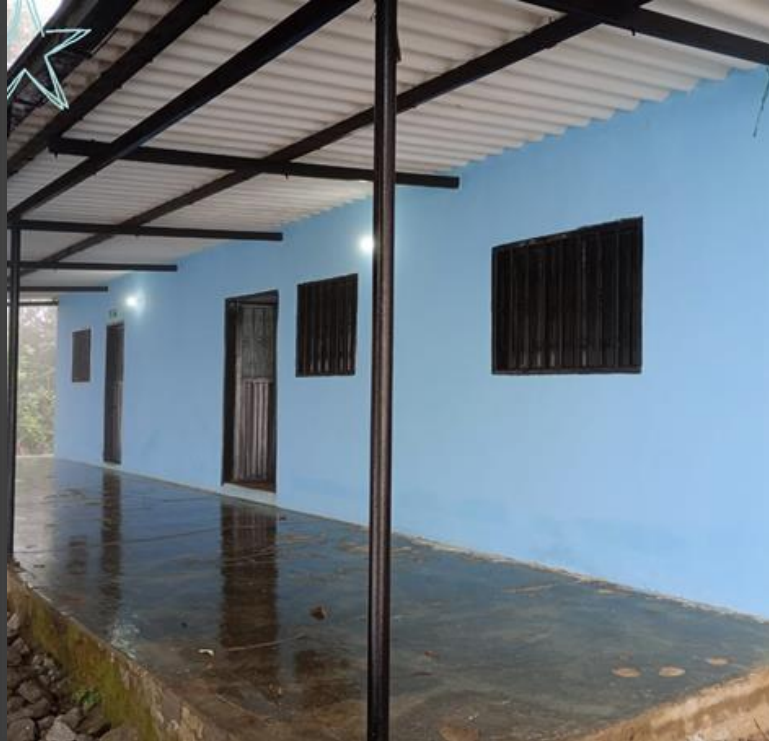
MANTENIMIENTO DE SEDE BUENOS AIRES
