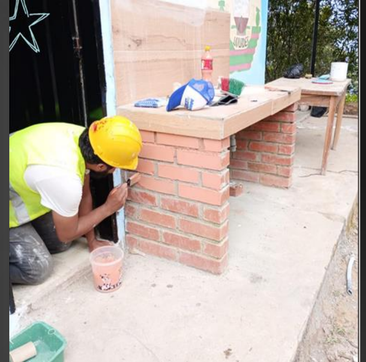
MANTENIMIENTO DE SEDE BUENOS AIRES
