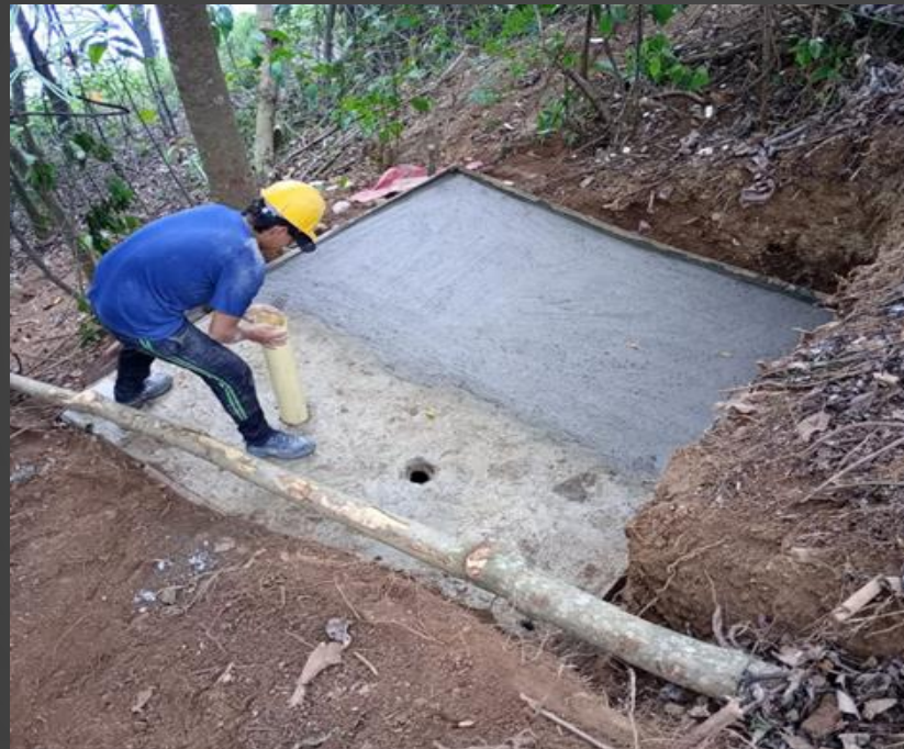
CONSTRUCCION DE UN POZO SÉ-PTICO SEDE BUENOS AIRES
