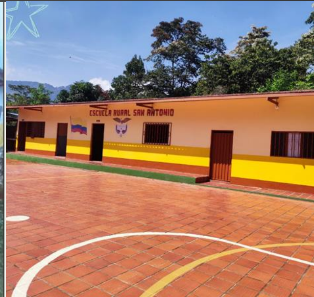
PINTURA Y DEMARCAACION DE LA CANCHA SEDE SAN ANTONIO
