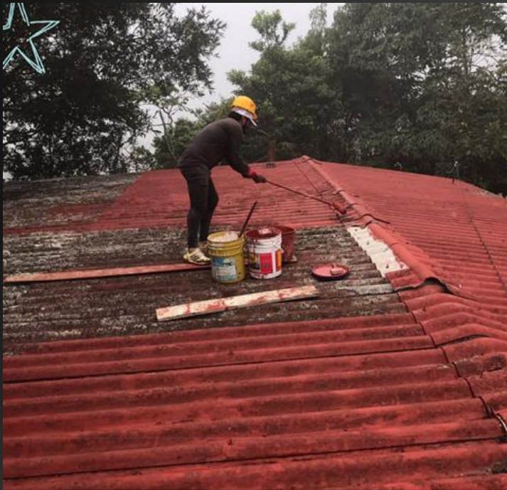
MANTENIMIENTO DE SEDE BUENOS AIRES
