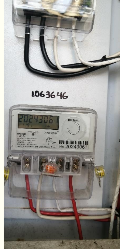
Instalación de contador y acometida eléctrica para la Tienda escolar
