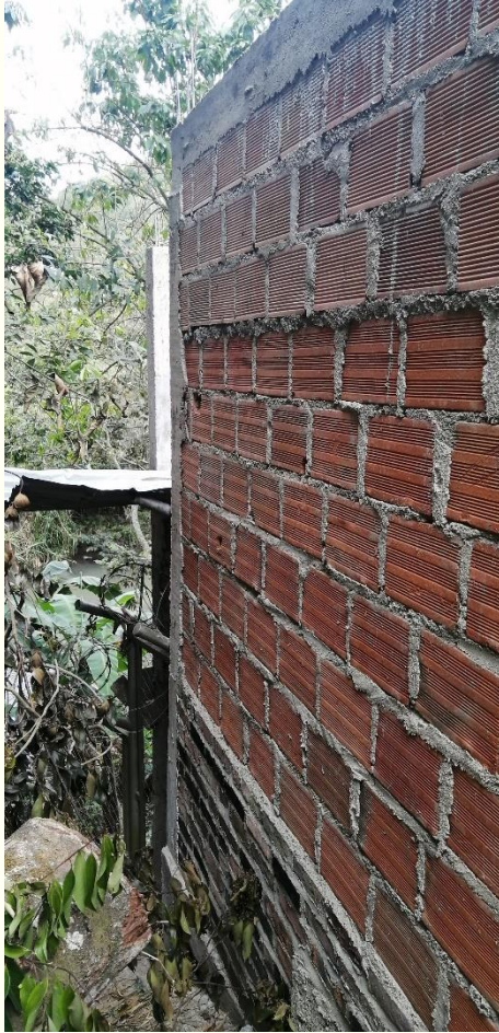
Construcción de muro en ladrillo y columnas
