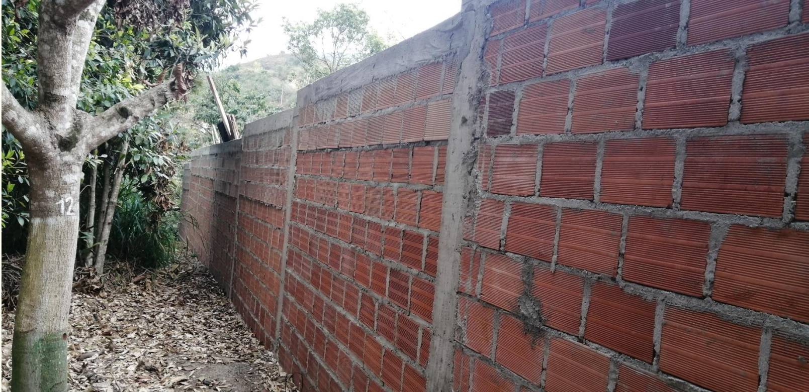
Construcción de muro en ladrillo y columnas
