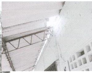
no están debidamente amarradas a la estructura lo que está ocasionando el desplazamiento de estas sobre la estructura o falta de apoyo.
