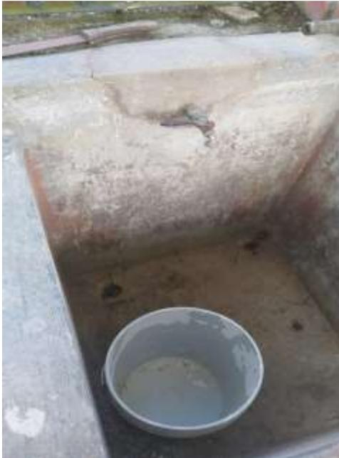
EL TANQUE DE ALMACENAMIENTO DE AGUA DE LA SEDE ESTA EN MUY MAL ESTADO Y SE DEBE REPARAR Y ENCHAPAR (PONER BALDOSA)
