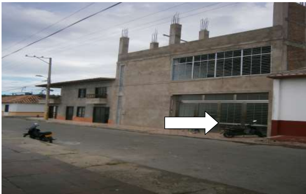
Foto 1. Vista entrada principal
