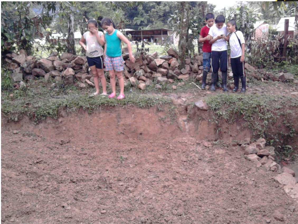
Arreglo del terreno
